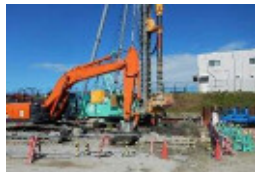
開削トンネル地盤改良工の実施状況
