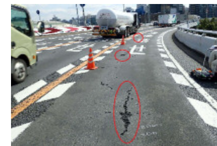
舗装の損傷
