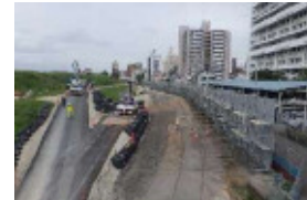
地中障害物撤去準備工の実施状況
