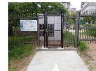
⑥ 地上部フェンス
