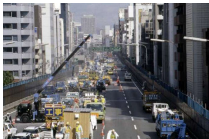
2002年の終日通行止め工事の様子
