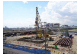
換気所土留壁工の実施状況
