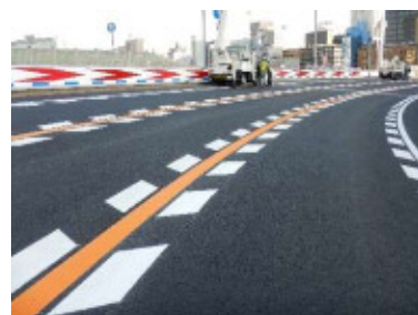
舗装の全面的な打ち換え
