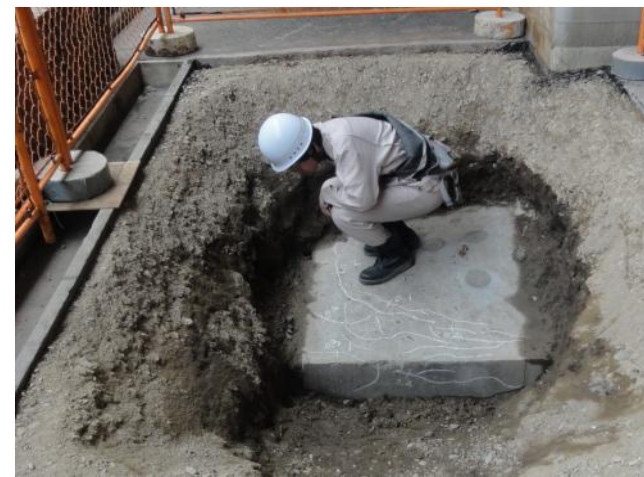
A S R橋脚 基礎調査
