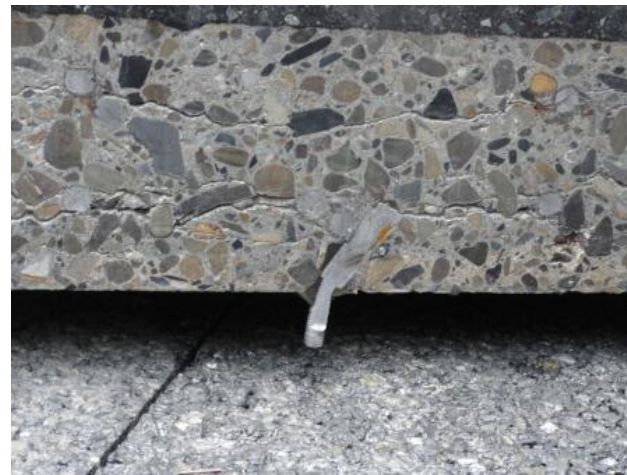
R C床版 切り出し
