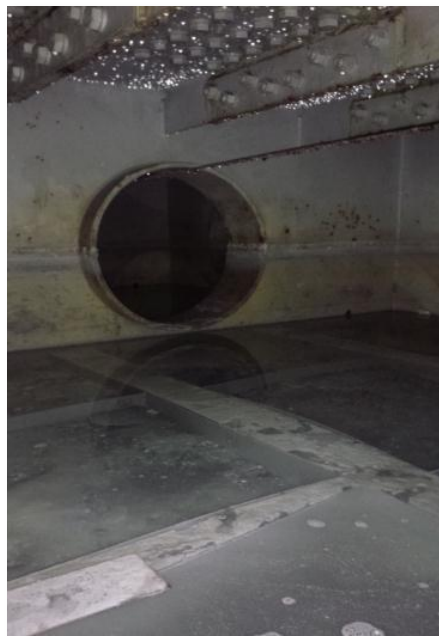
湊町鋼製 フーチング
