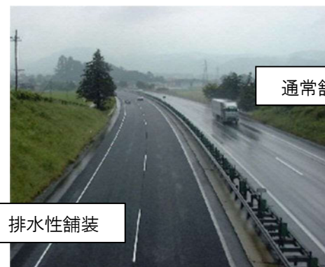
排水性舗装の施工例
