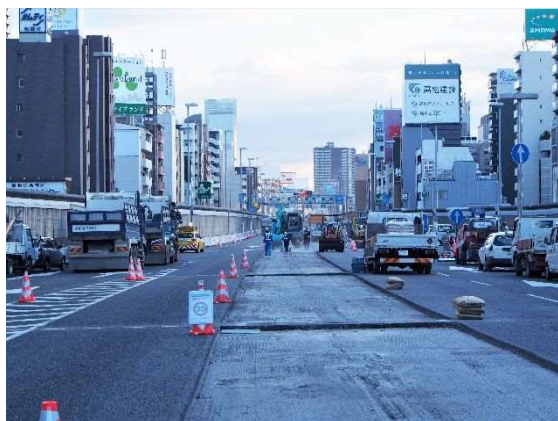
1号環状線(南行)リニューアル工事の様子(2020年11月)
