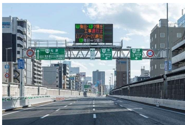
1号環状線(南行)リニューアル工事完了後の様子
