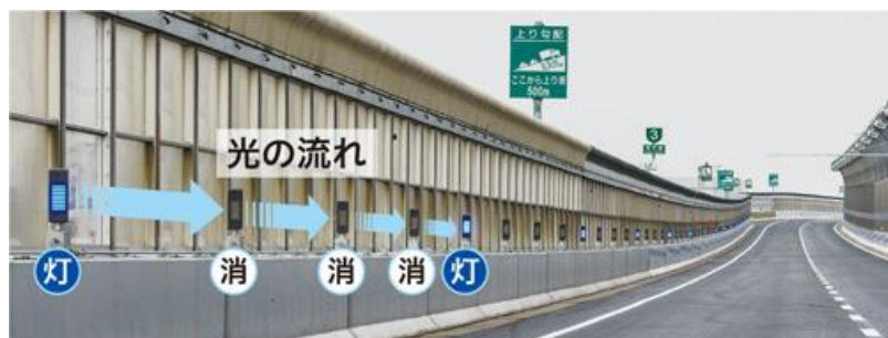
3号神戸線(東行き)深江サグ付近
