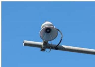
超音波式車両検知器
