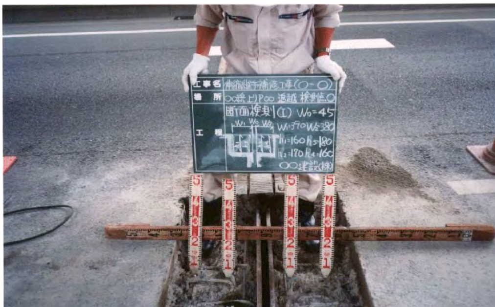
伸縮継手切削断面の計測
