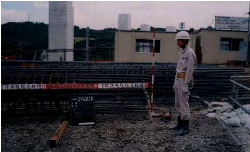
鉄筋かご実長の接写の例
