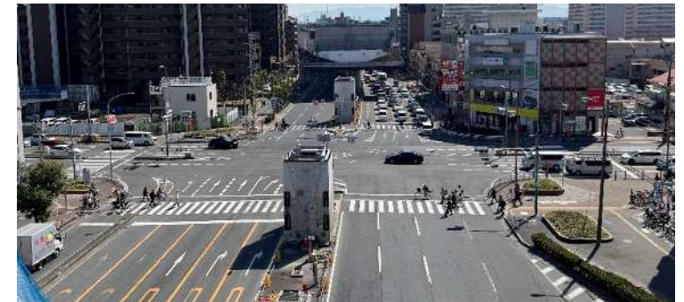
既設コンクリート橋梁の撤去完了
