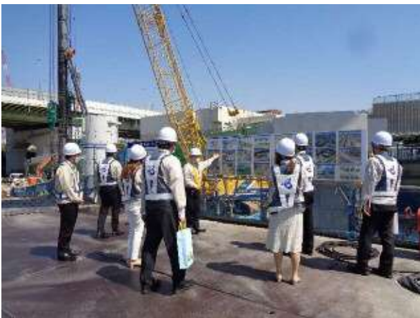
〔淀川左岸線(2期)工事現場 視察状況〕
