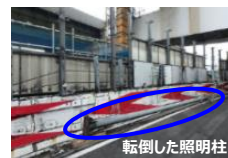
工事中の照明柱転倒（3号神戸線）を受け、鋼製高欄の内部を全数緊急点検（H31.3）
