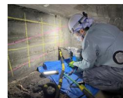
グラウト充填調査 (2021年10月撮影)
