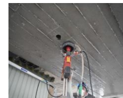
コア削孔調査 (2021年10月撮影)
