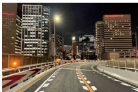
■LED道路照明（明かり部）
