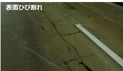
2016年度の臨時点検で発見されたPC舗装(新神戸トンネル)の損傷
