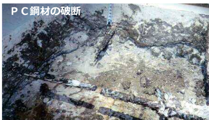
2016年度の臨時点検で発見されたPC舗装(新神戸トンネル)の損傷
