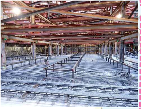
函体工の実施状況
