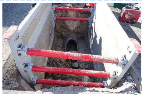
支障物撤去工の実施状況
