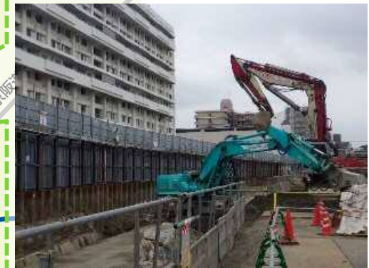
障害物撤去工の実施状況
