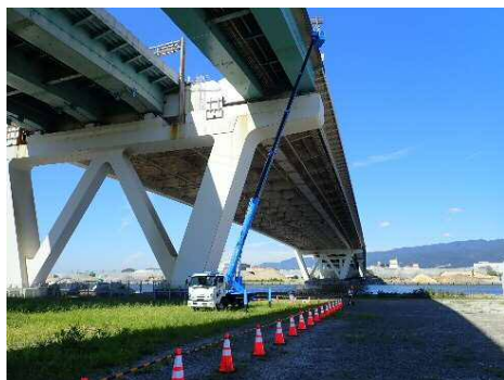
一般県道芦屋鳴尾浜線 橋梁定期点検
