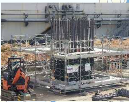
RC橋脚工の実施状況
