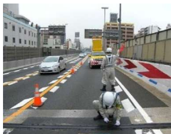
日常点検（路上点検）
