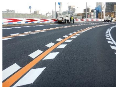
舗装の全面的な打ち換え
