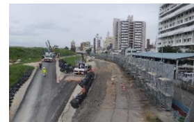
地中障害物撤去準備工の実施状況
