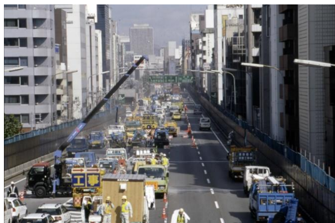
2002年の終日通行止め工事の様子
