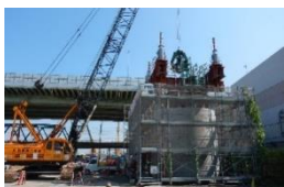
橋脚基礎工の実施状況
