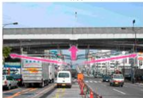
ケーブルで左右から引き上げて中央を持ち上げる対策を実施。
