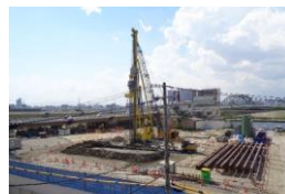
換気所土留壁工の実施状況
