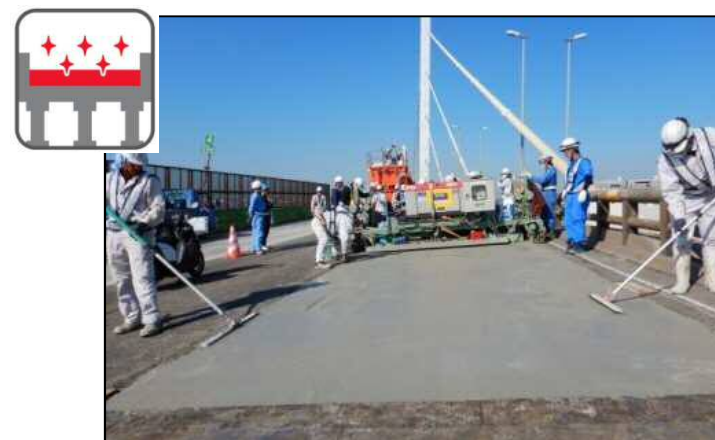
SFRC舗装※ (2019年度 4号湾岸線 (南港北～大浜))
