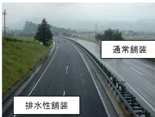
排水性舗装の施工例
