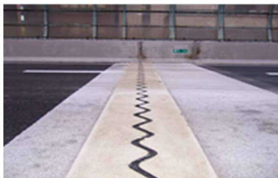
①-2.新しい伸縮継手への取り替え
