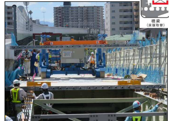
UFC床版架設工事の状況（玉出入口※）
