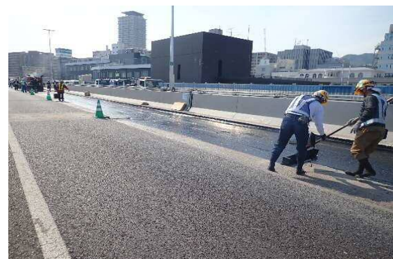
②高性能床版防水の施工
