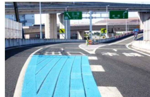
誤退出防止対策（カラー舗装）の例
