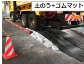
土のう+ゴムマット
