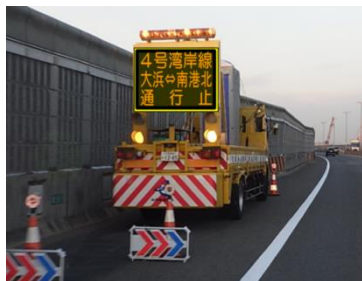
⑥仮設LED表示板(標識車)
