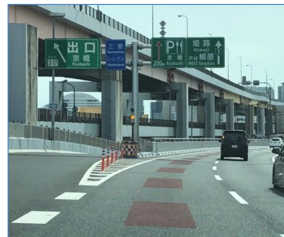
京橋出口と京橋PAの連続分岐（6/3）
