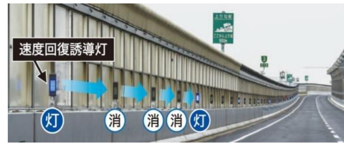
④ 速度回復誘導灯による渋滞対策
