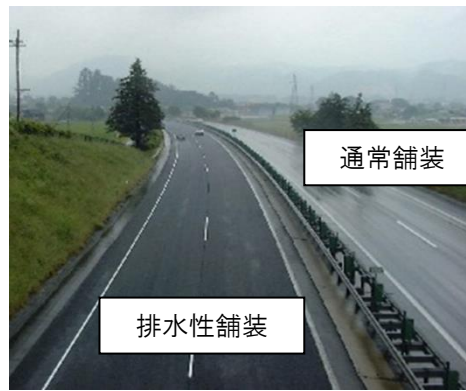
② 高性能舗装による安全性向上
