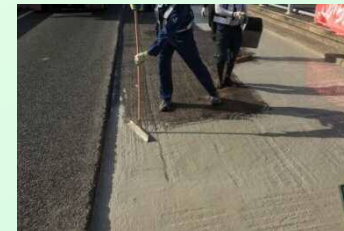
高性能床版防水施工状況
