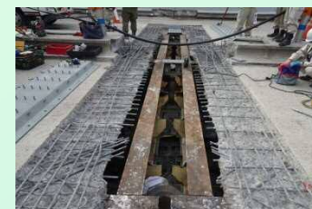
床版連結施工状況
