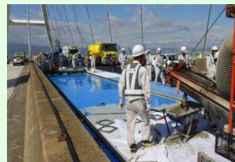
SFRC舗装打設状況
