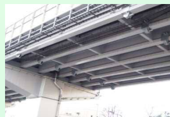
アウトケーブル補強状況
