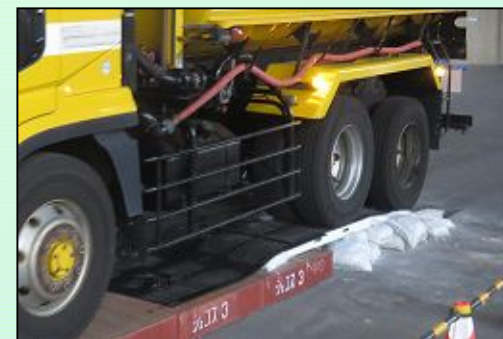
〔路面段差の応急復旧イメージ〕
