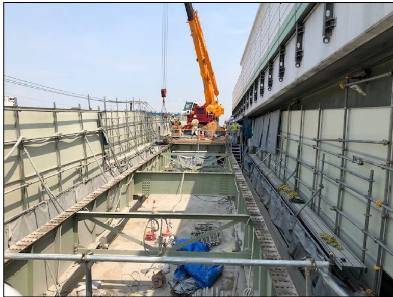
〔損傷したRC床版の撤去〕
