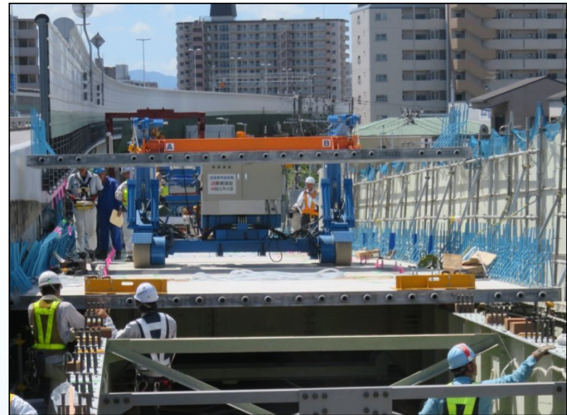
〔新しいRC床版の設置〕
