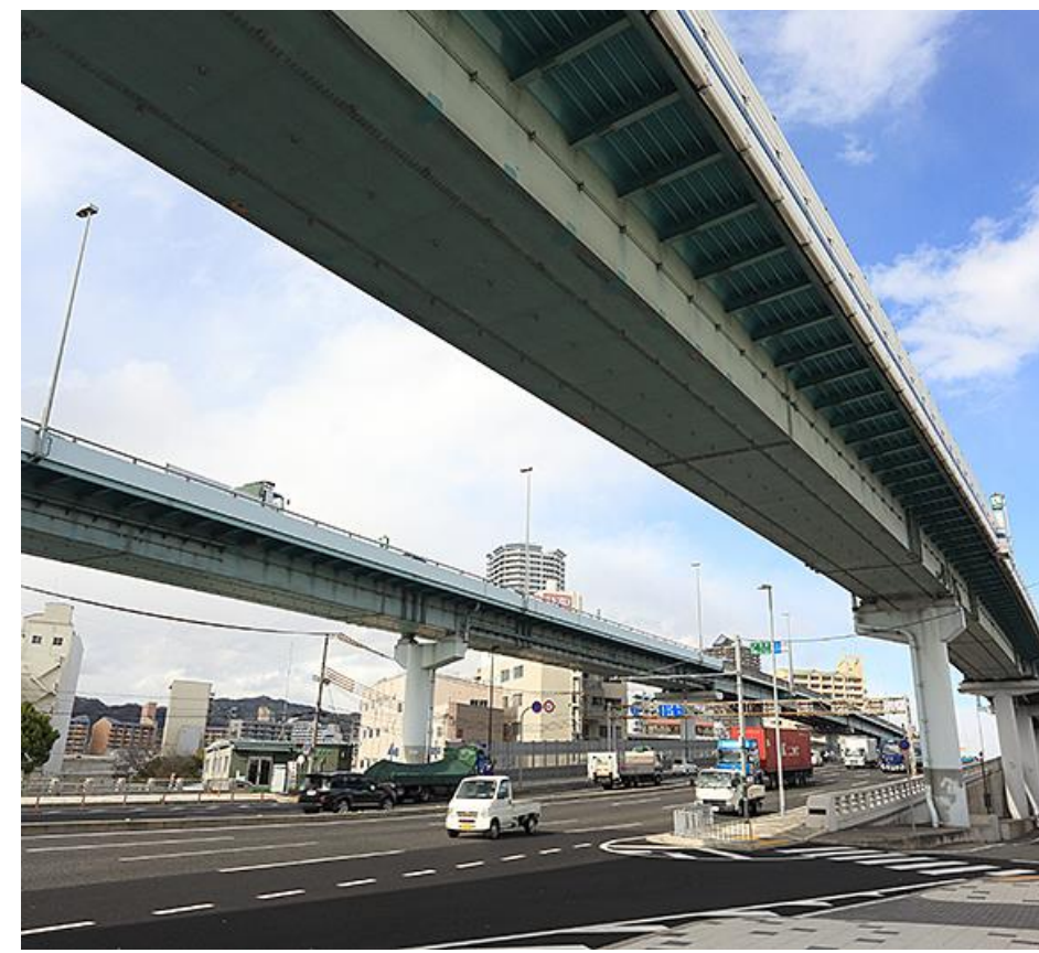
湊川付近の鋼床版箱桁
