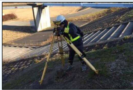
淀川左岸線延伸部 測量調査実施状況
