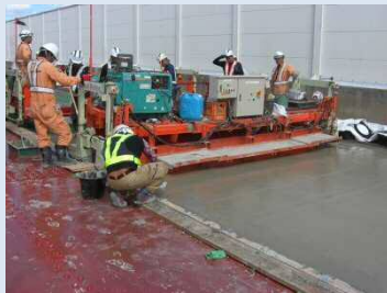
SFRC舗装打設状況
