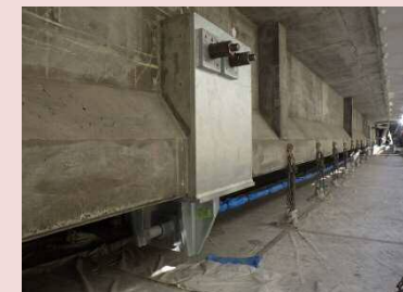
アウトケーブル補強状況
