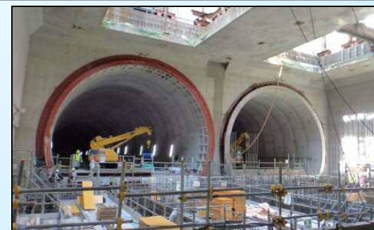
大和川線 シールドトンネル立坑部 施工状況
