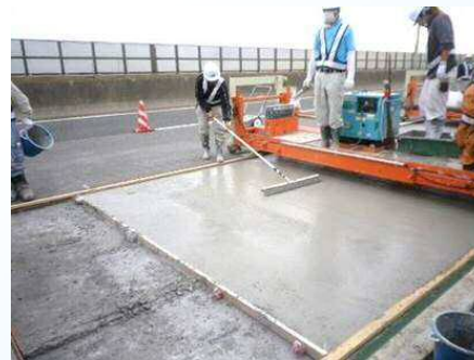
SFRC舗装により鋼床版の耐久性を向上
