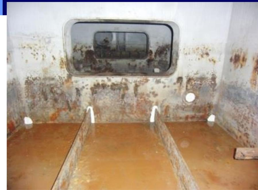
写真 内部の腐食状況
