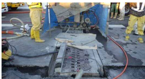
＜ ※1）伸縮継手低騒音切断撤去工法 ＞
