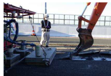
＜ ※2）電磁誘導加熱（IH）による鋼床版As舗装撤去工法 ＞
