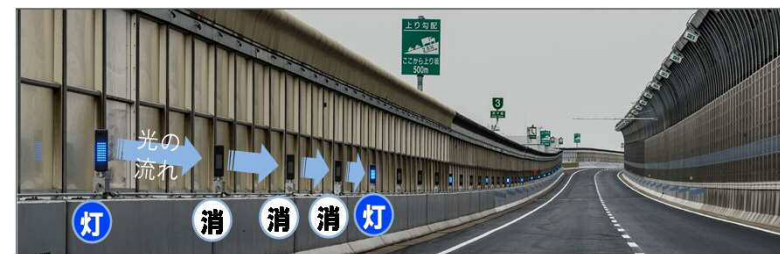
[深江付近に設置した速度回復誘導灯]
