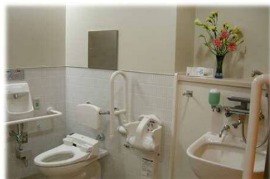
〔トイレの拡充 (温水洗浄便座・多機能トイレ)〕
