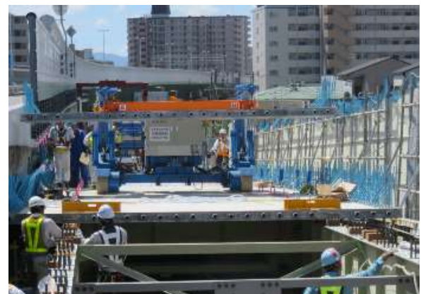
床版の取替状況
