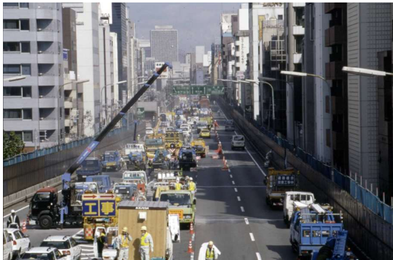
前回の1号環状線大規模補修工事の様子（2002年）
