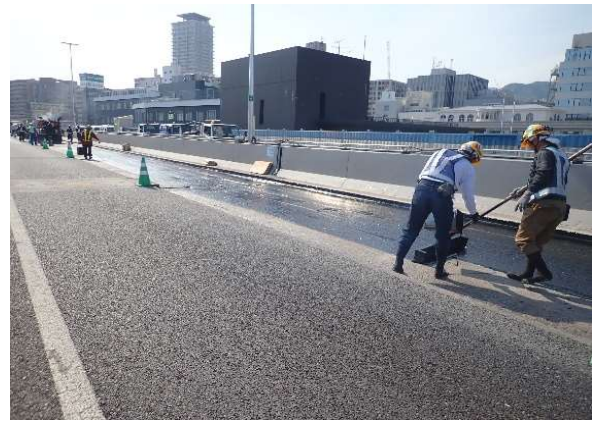
高性能床版防水の施工状況
