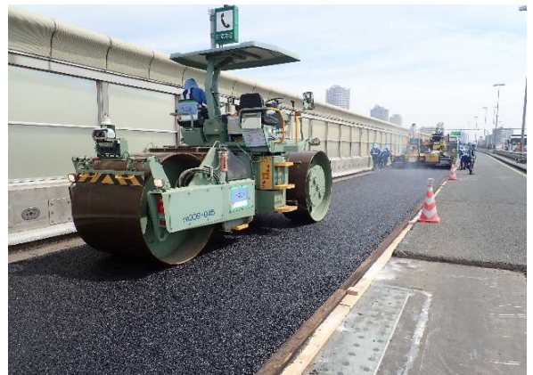
舗装の全面打ち換え状況
