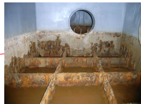
鋼製フーチング内部腐食状況
