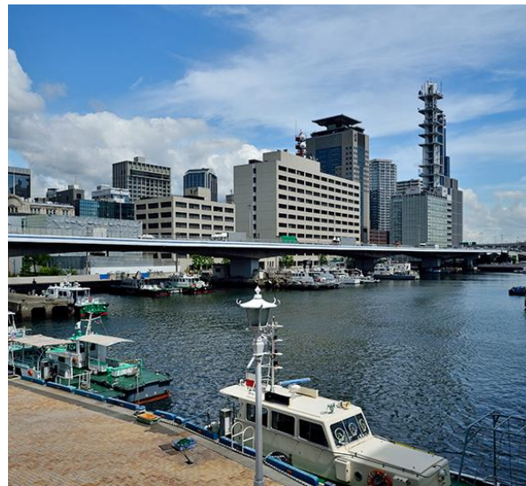
⑤3号神戸線京橋付近
