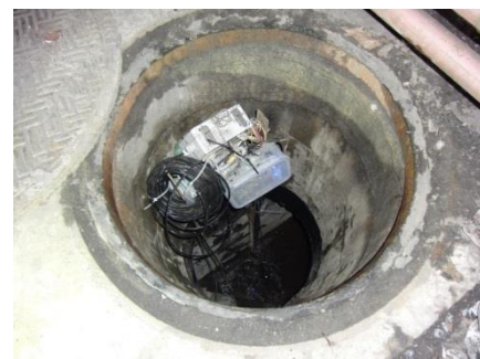
進入用マンホール
