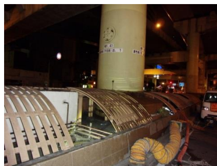
調査状況(夜間交通規制)
