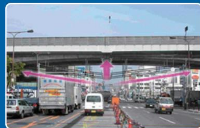
ケーブルで左右から引き上げて中央を持ち上げる対策を実施
