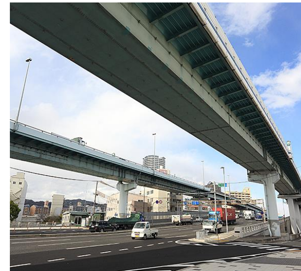
⑥3号神戸線湊川付近
