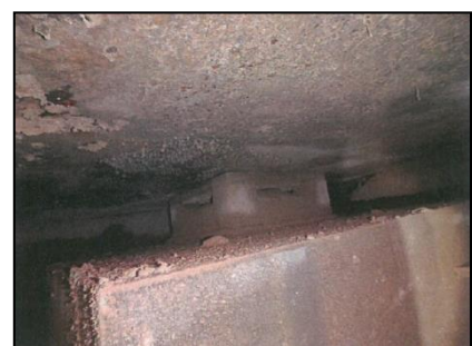
堺下P41(北)鋼製フーチング支承部の状況
