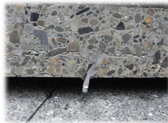
切断面及びひび割れ発生状況
