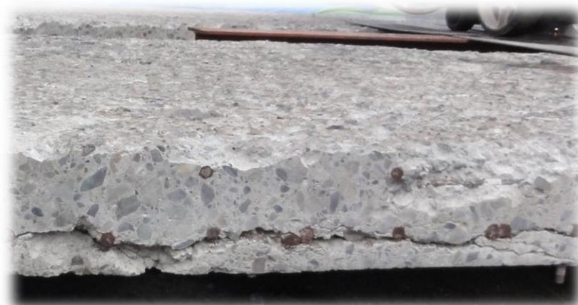
切断面の水平ひび割れ
