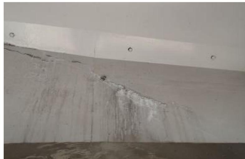
ひび割れ、漏水・遊離石灰（Aランク）
