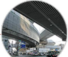
15号堺線 湊町付近
