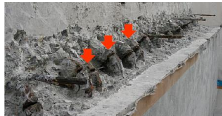
コンクリート内部の鉄筋破断
