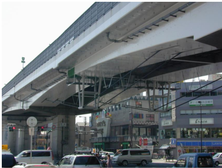
ストラット部材を用いた下弦ケーブル補強
