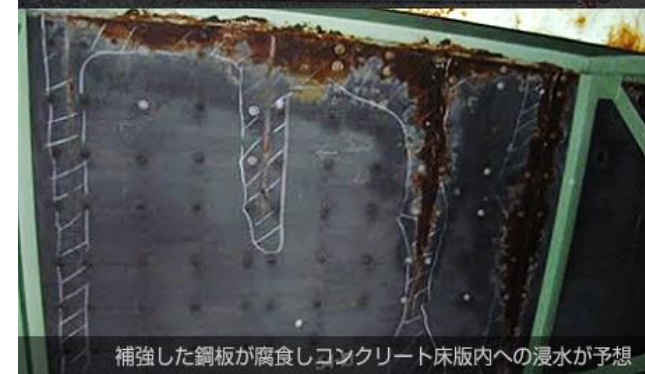
陥没したコンクリート床版
