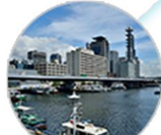
3号神戸線 京橋付近
