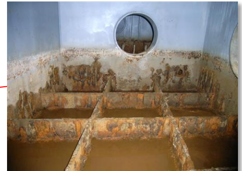
鋼製フーチング内部腐食状況
