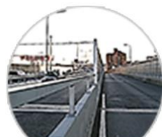
11号池田線 大豊橋付近
