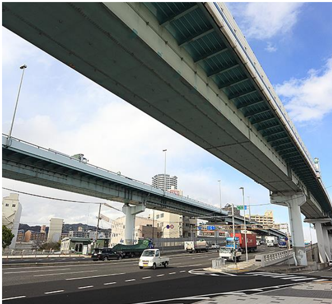
国道2号と側道の状況
