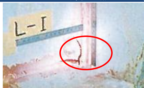
主桁横桁交差部のき裂
