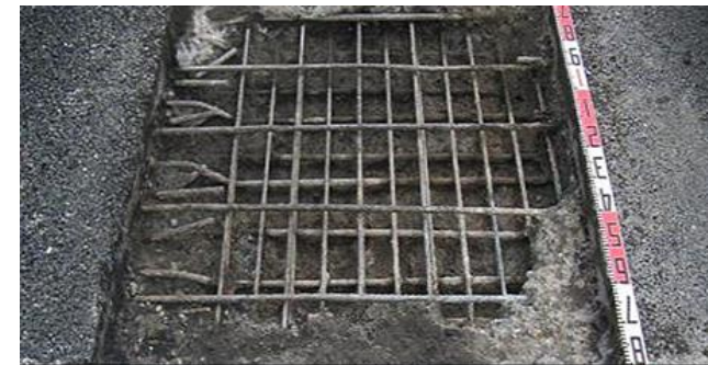
陥没したコンクリート床版
