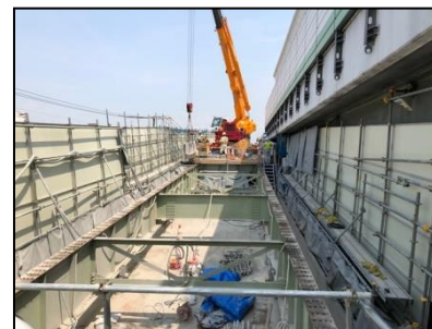
損傷したRC床版の撤去
