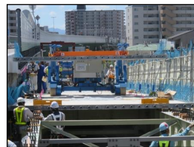
新しいプレキャスト床版の設置
