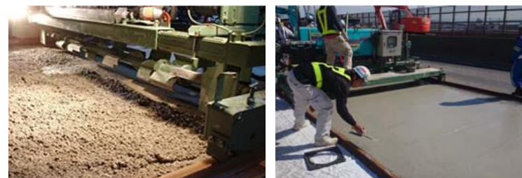
SFRC舗装 施工状況
